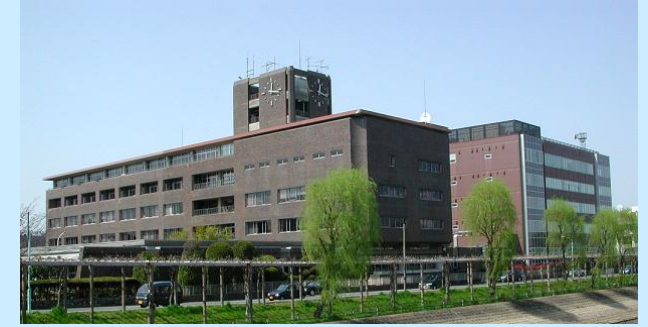
(建て替えが必要な越谷市役所本庁舎)
