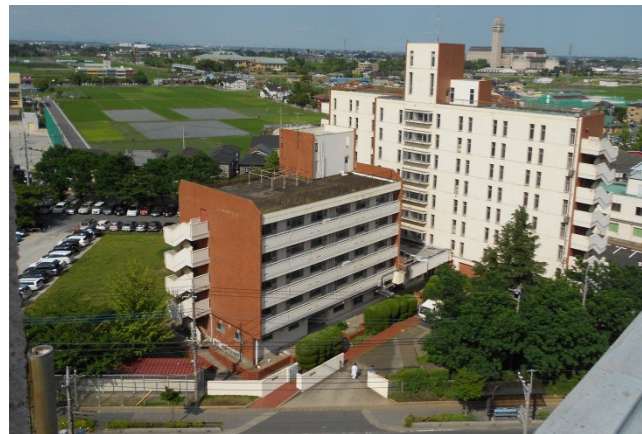
旧看護専門学校宿舍の現在の様子。この2棟の建物を解体して、保健所が建設されます
